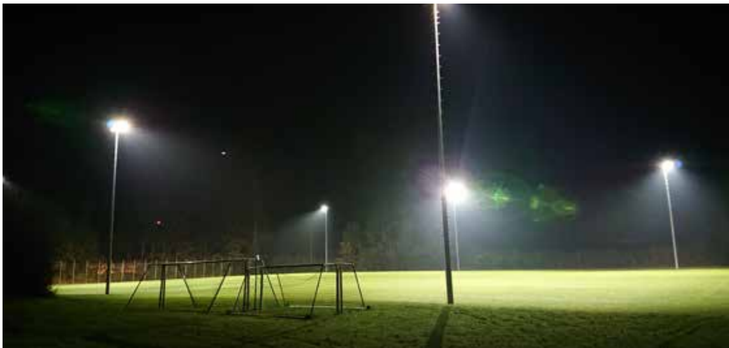
Nicht nur enorm sparsamer, sondern auch viel heller – die sanierte Flutlichtanlage im Beutwang
